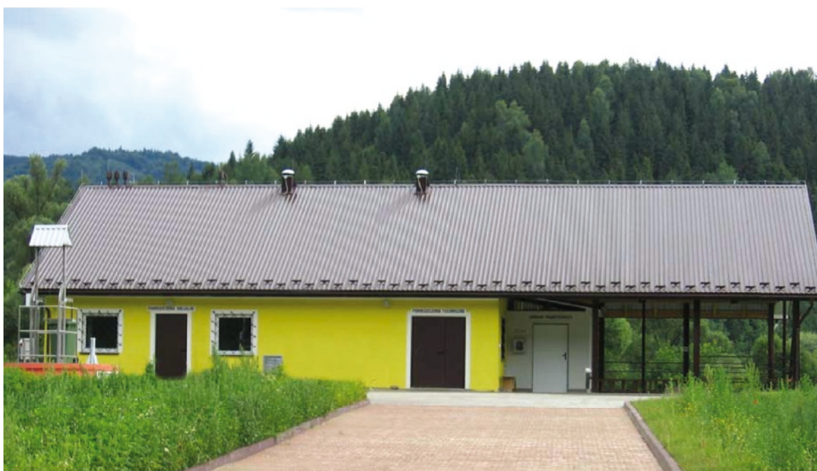
Oczyszczalnia ścieków w Andrzejówce
