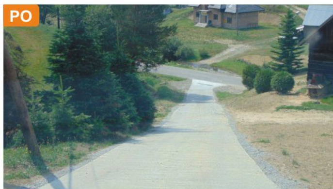
Droga rolna w Jastrzębiku wykonanie częściowo z płyt ażurowych i betonu wartość projektu: 76 452,11 zł
