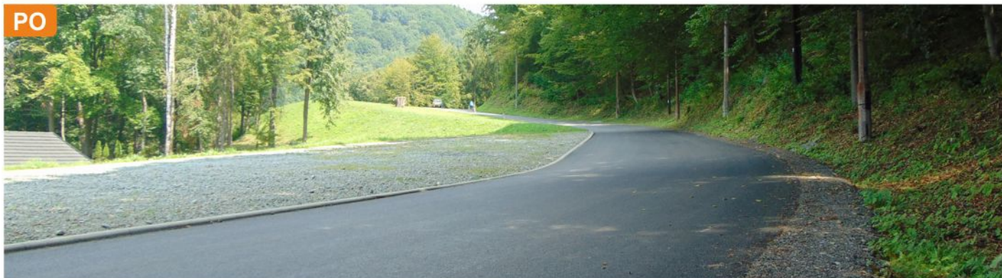
Odbudowa drogi gminnej - „Łopata” w Żegiestowie wartość projektu: 403 044,49 zł
