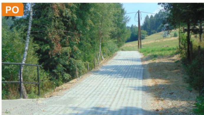
Droga rolna w Jastrzębiku wykonanie częściowo z płyt ażurowych i betonu wartość projektu: 76 452,11 zł
